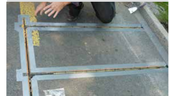
Poste de comptage permanent avec piézo. Uniquement sur des surfaces lisses, pas sur des pavés. Jusqu'à une largeur de 5 mètres par voie.
