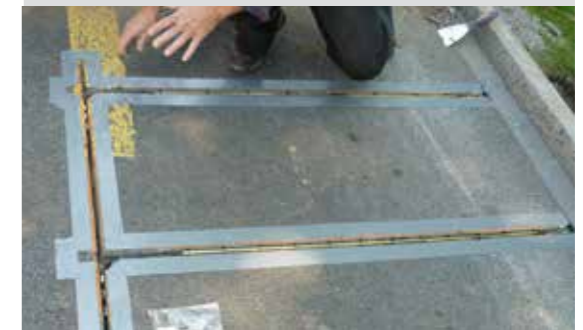
Installation einer Dauerzählstelle mit Piezo. Nur auf glatten Oberflächen, keine Pflasterung. Bis max. 5m Breite pro Fahrspur.
